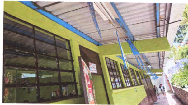
Foto 8: Sustitución de ducto eléctrico + accesorios
