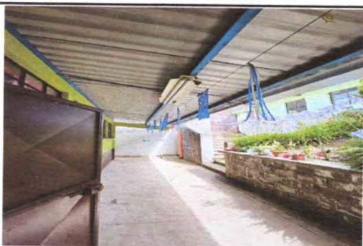
Foto 5: Sustitución de lamparas tipo LED
