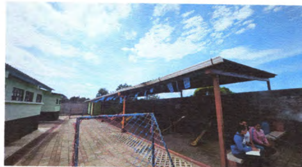
Foto 2: Sustitución de canal de metal
