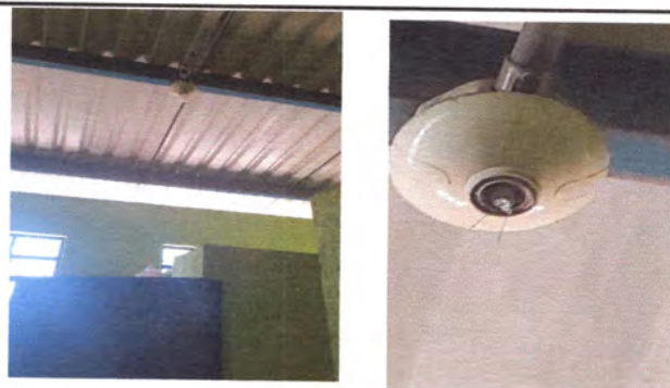
Foto 6: Sustitución de focos ahorradores
