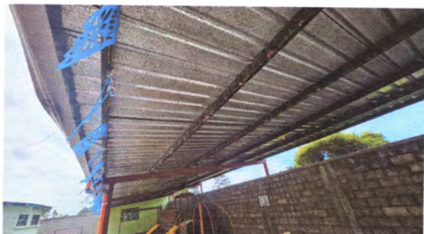
Foto 1: Sustitución de lámina, por lámina troquelada aluzinc calibre 26 y mantenimiento a estructura de soporte de metal
