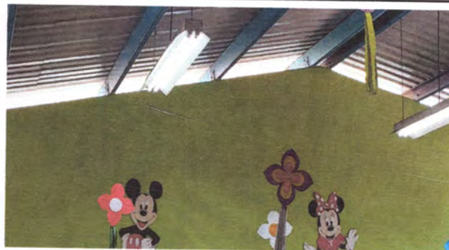
Foto 10: Protección con duela de PVC en paredes más aplicación de espuma expansiva
