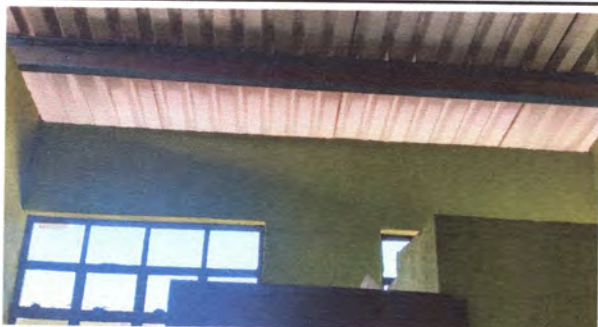
Foto 11: Protección con duela de PVC en paredes más aplicación de espuma expansiva
