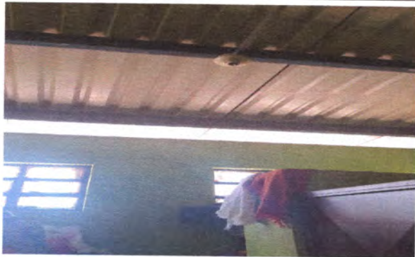
Foto 7: Sustitución de plafoneras
